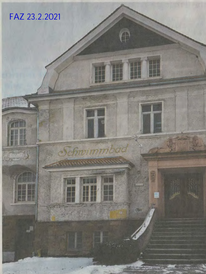
Aus dem Dornröschenschlaf erwacht: Friedbergs altes Hallenbad
