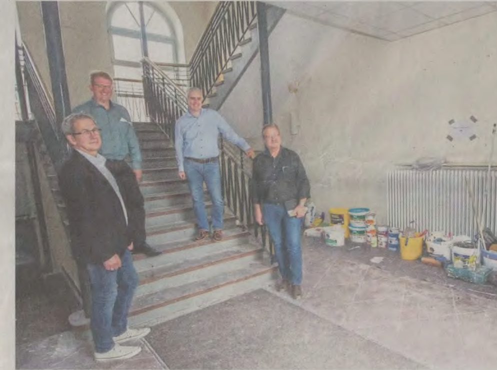
Kurz vor Abschluss: Die letzten Umbauarbeiten im Erdgeschoss der ehemaligen Hans-Memling-Schule laufen auf Hochtouren.
