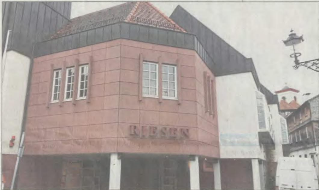
Seligenstadts „Gud Stubb“, der Riesensaal: Die jährlichen Erträge bleiben weit hinter den Aufwendungen zurück, das Defizit ist erheblich. ■ Foto: mho
