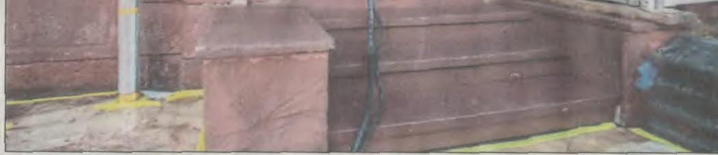
Des schönen Sandsteinsockels wird der Passant erst seit Kurzem gewahr, doch schon bald soll die Fassade des ehemaligen Rathauses in Altheim wieder ergrauen.
