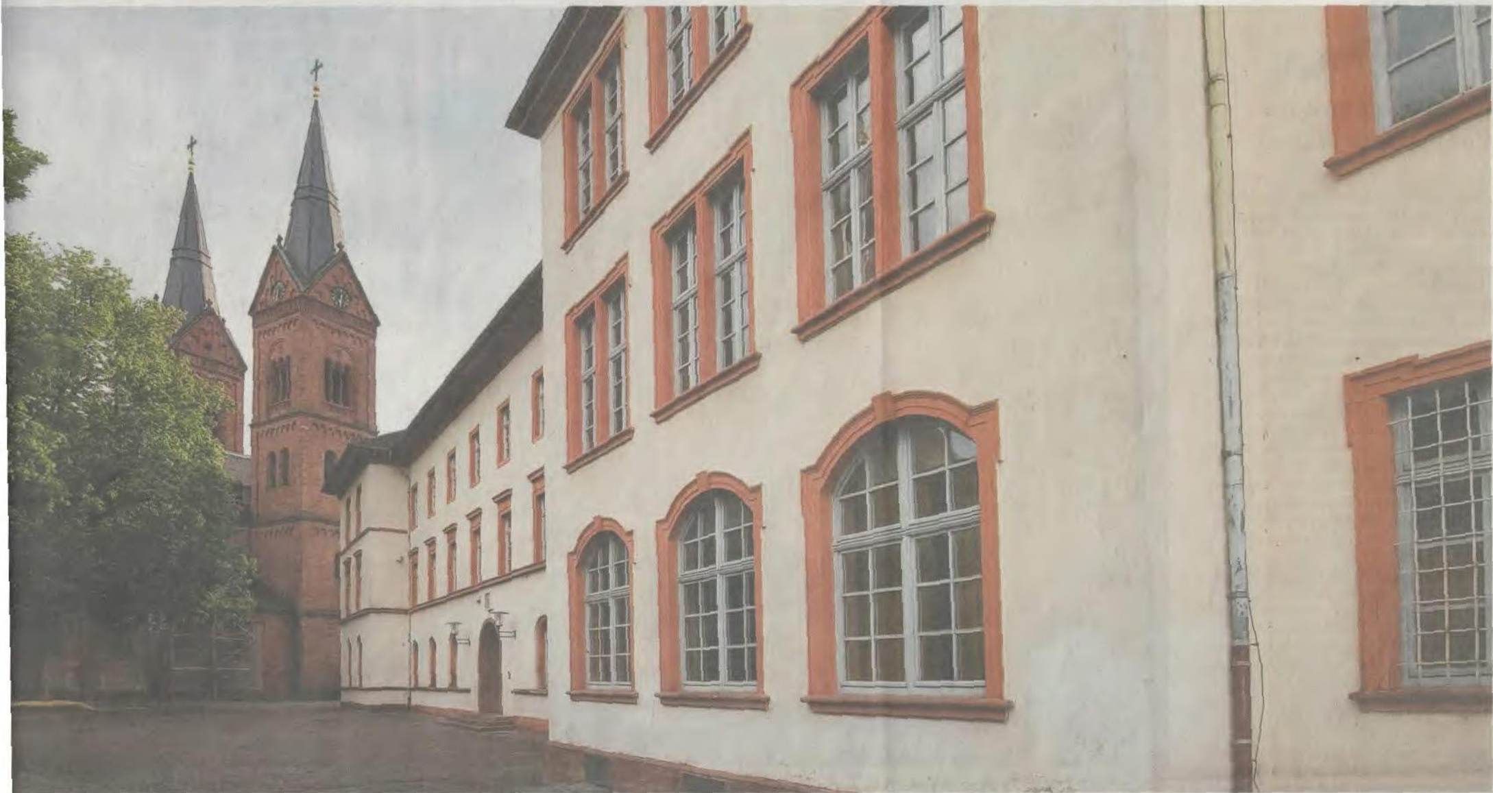
age: Das Schulgebäude an der Einhardbasilia steht seit 2012 leer.
