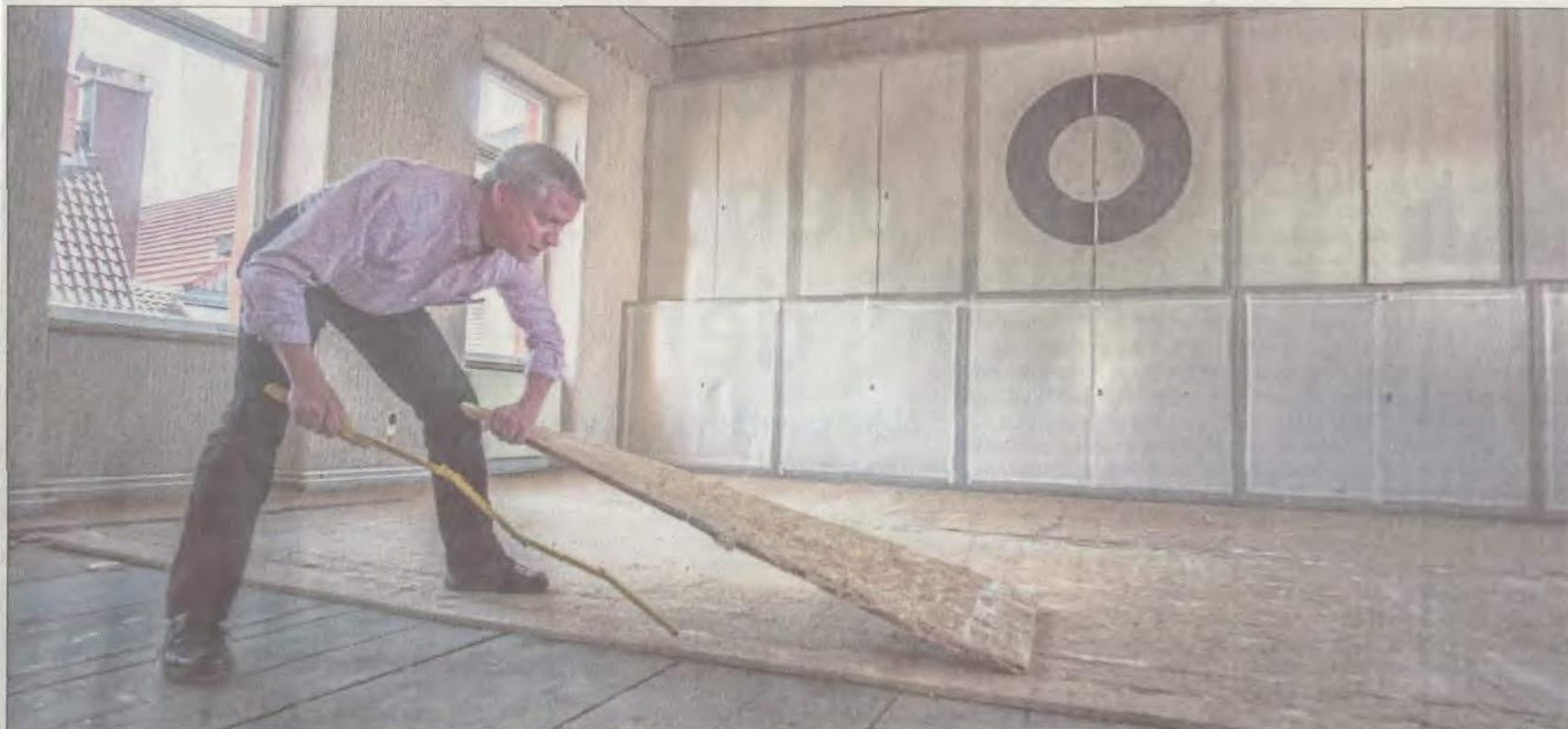
Architekt Michael Kramer aus Eppertshausen packt's an: Die ersten Handwerker sind im ehemaligen Rathaus Altheims bereits am Sanierungswerk und der Verein „ARThaus“ langte beim Ausräumen im Vorfeld kräftig zu. Bis Herbst soll außen und innen alles saniert sein. • Fotos: Th. Meier
