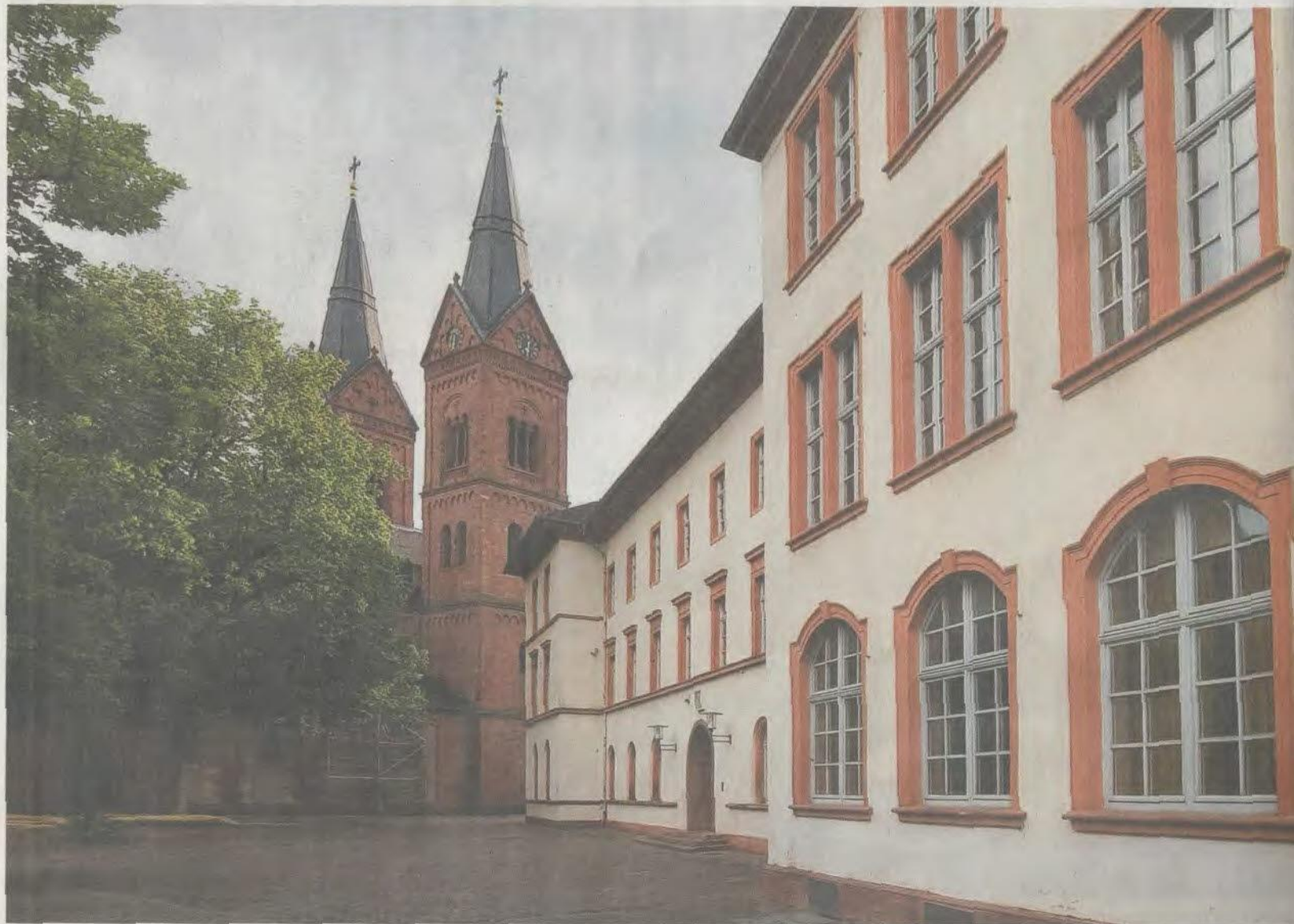
In exponierter Lage: Das Schulgebäude an der Einhardbasilia steht seit 2012 leer.
