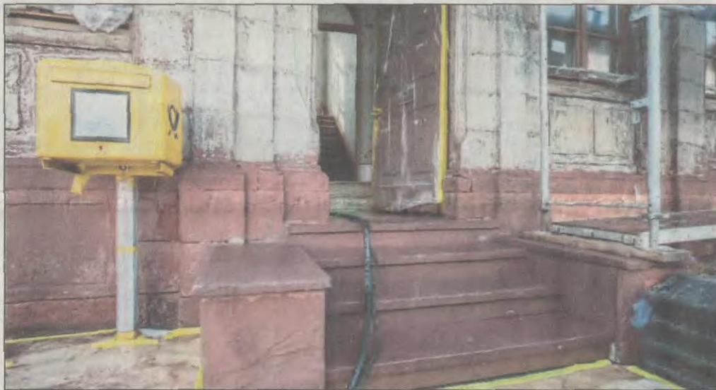
Des schönen Sandsteinsockels wird der Passant erst seit Kurzem gewahr, doch schon bald soll die Fassade des ehemaligen Rathauses in Altheim wieder ergrauen.
