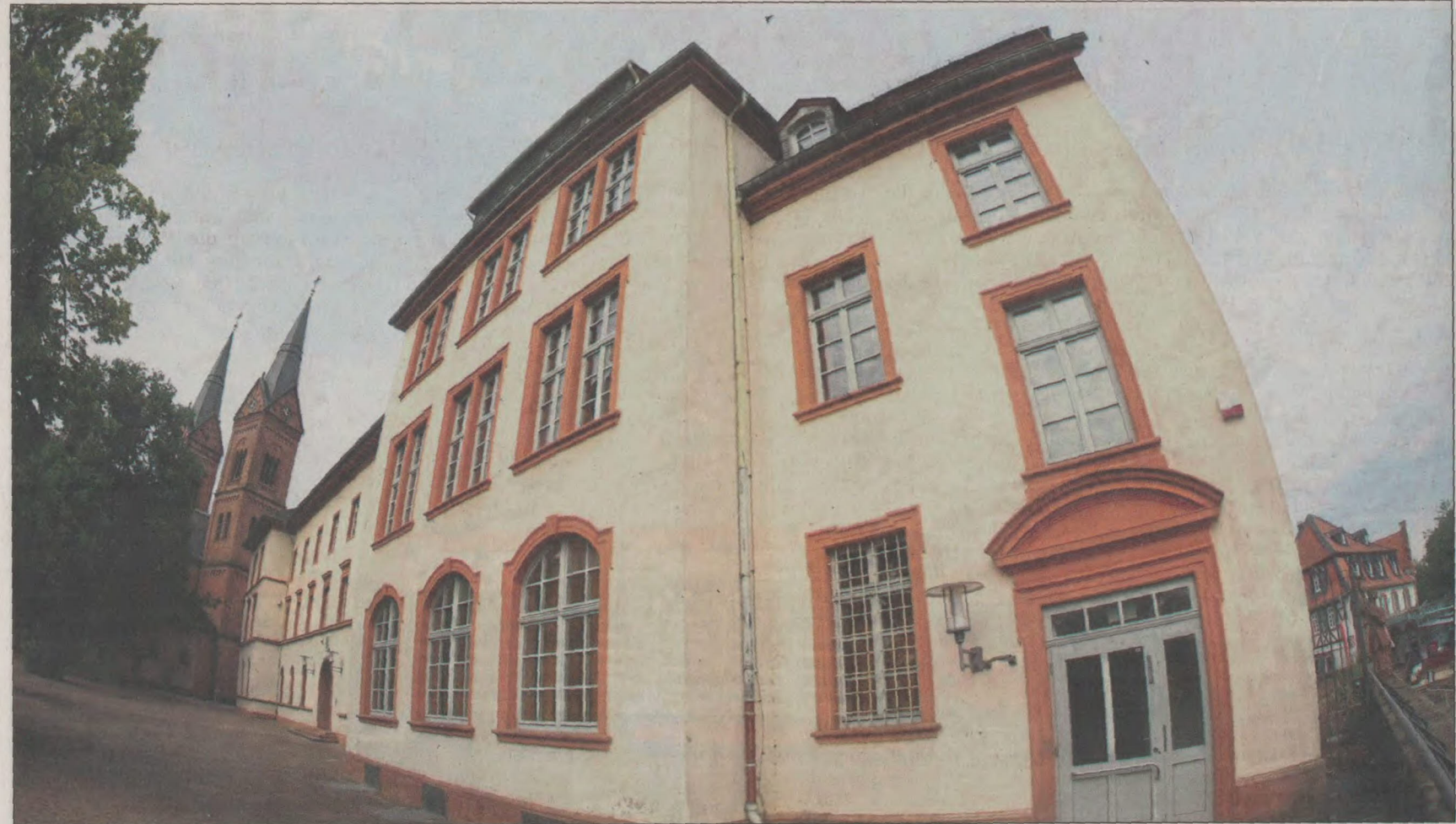
Der Gebäudekomplex der seit dem Jahr 2012 leer stehenden Seligenstädter Hans-Memling-Schule: Trotz Sanierungsbedarfs ist der Zustand nach Ansicht von Bürgermeister Dr. Daniell Bastian deutlich besser als viele annehmen. ■ Foto: mho
