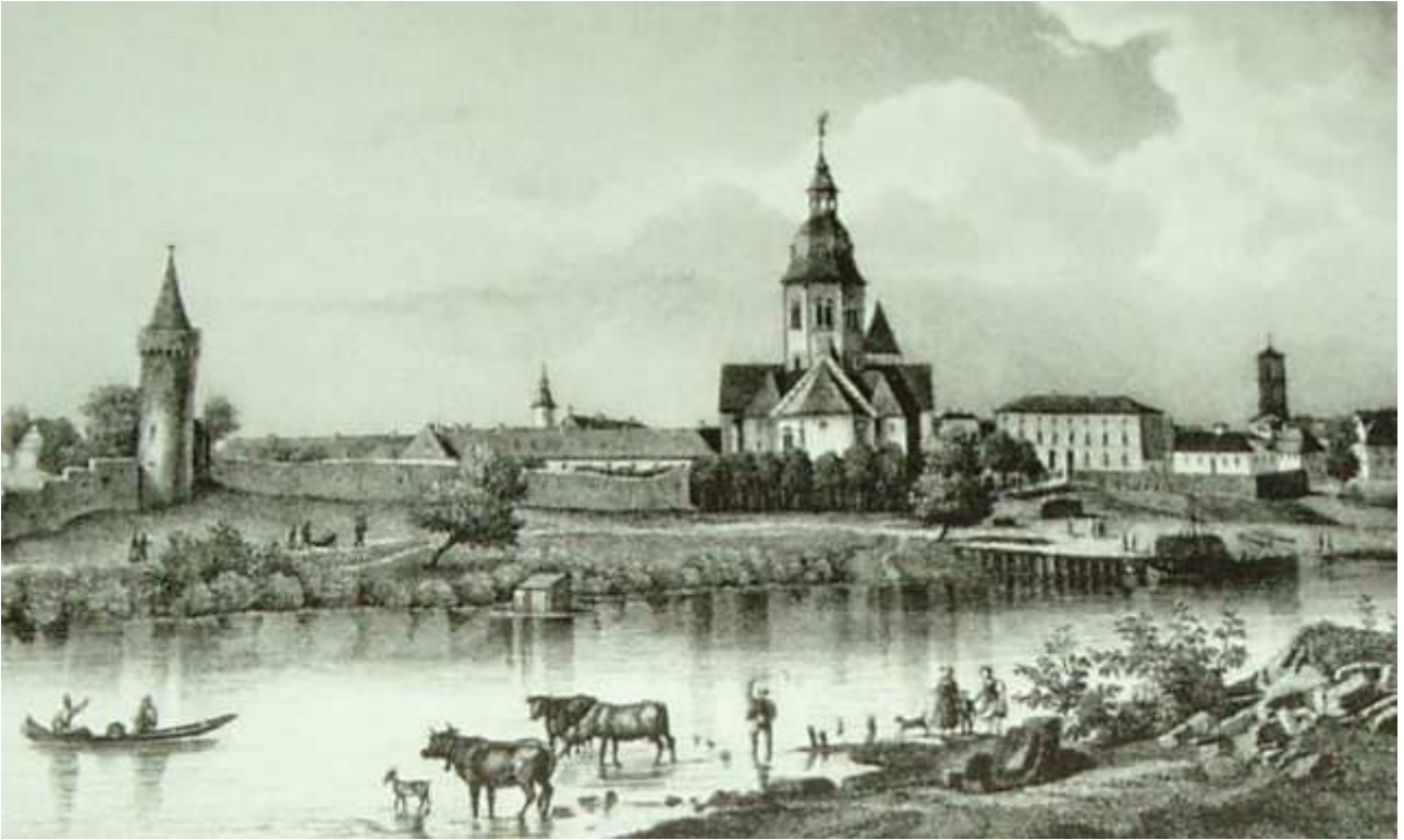
Abbildung 6: Stich Bamberger 1843 mit der ersten von insgesamt drei Bauphasen der Hans-Memling-Schule
