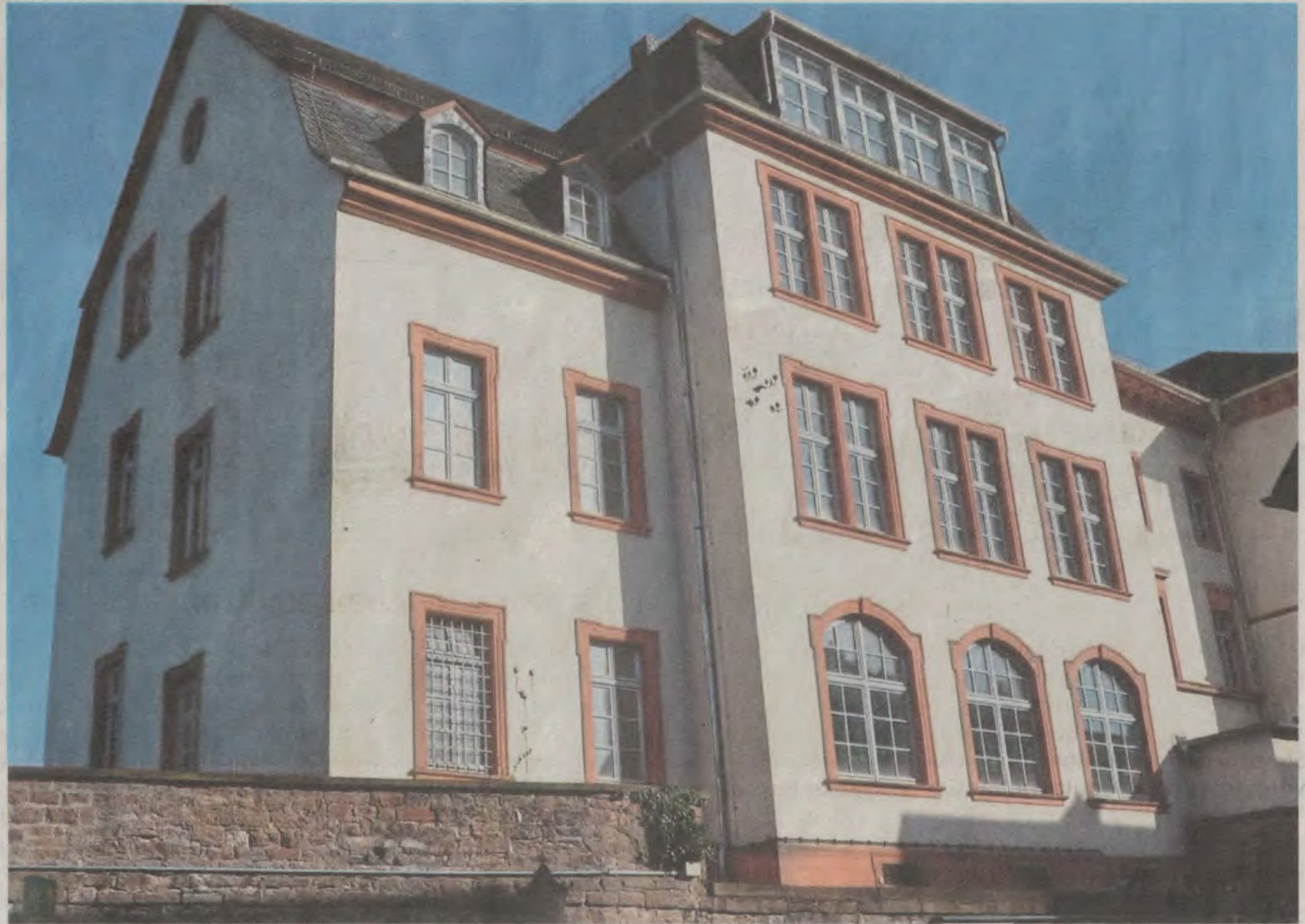
Die Arbeiten beginnen: In der seit 2012 leer stehenden Hans-Memling-Schule wird zunächst das Erdgeschoss hergerichtet. Die Komplettanierung ist für die kommenden Jahre geplant.
