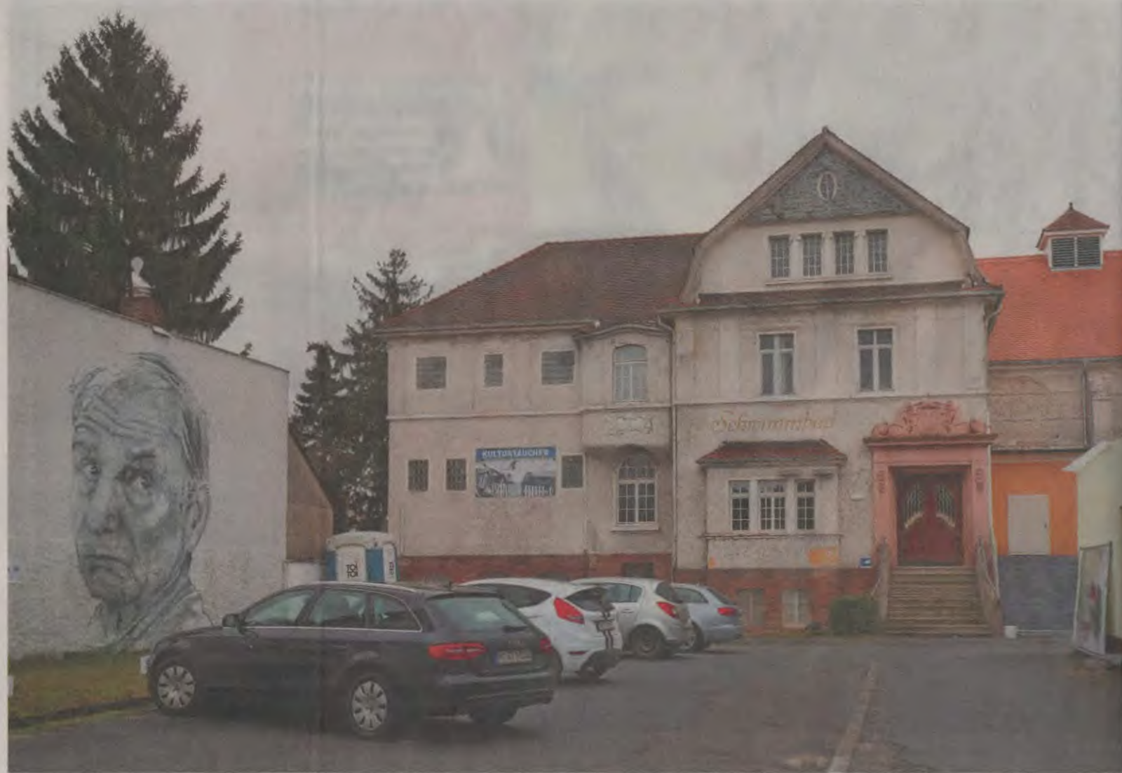
Theater statt Freischwimmer: Auch die Fassade des Alten Hallenbads in Friedberg, das inzwischen eine Kulturstätte ist, soll saniert werden.
