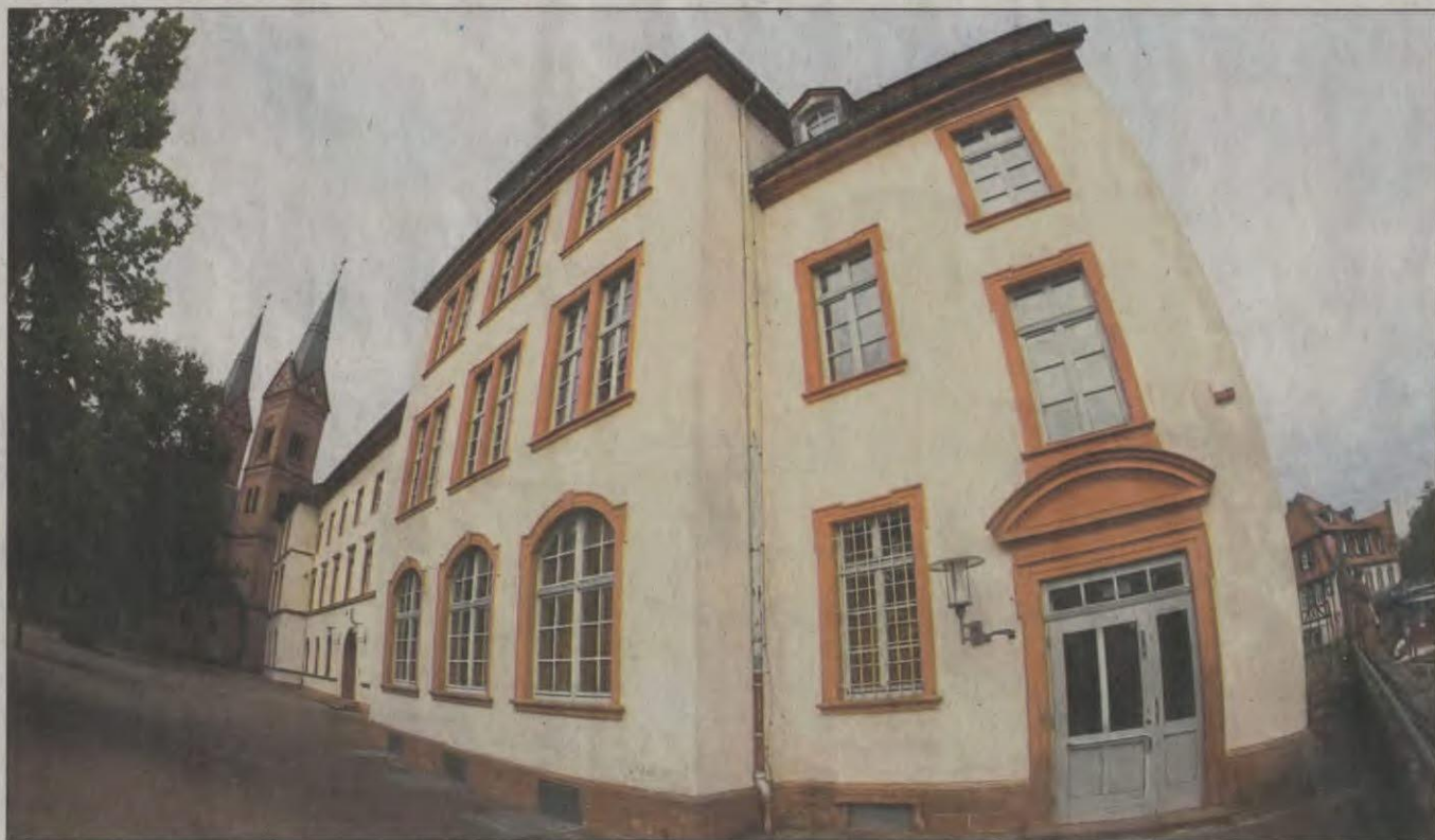
HMS-Areal: Die Offenbacher Erasmus-Schule hat Interesse am seit Jahren leer stehenden Gebäude am Seligenstädter Mainufer. Allerdings ist zuvor eine umfangreiche Sanierung erforderlich. ■ Foto: mho
