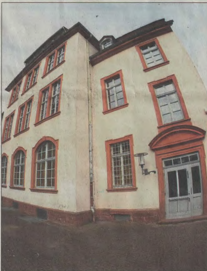
Früheres HMS-Gebäude: „Ausschließlich als Schulhaus genehmigt“, sagt die Bauaufsicht und zeigt die rote Karte. ■ Foto: mho
