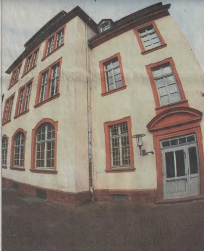
Früheres HMS-Gebäude: „Ausschließlich als Schulhaus genehmigt“, sagt die Bauaufsicht und zeigt die rote Karte. ■ Foto: mho
