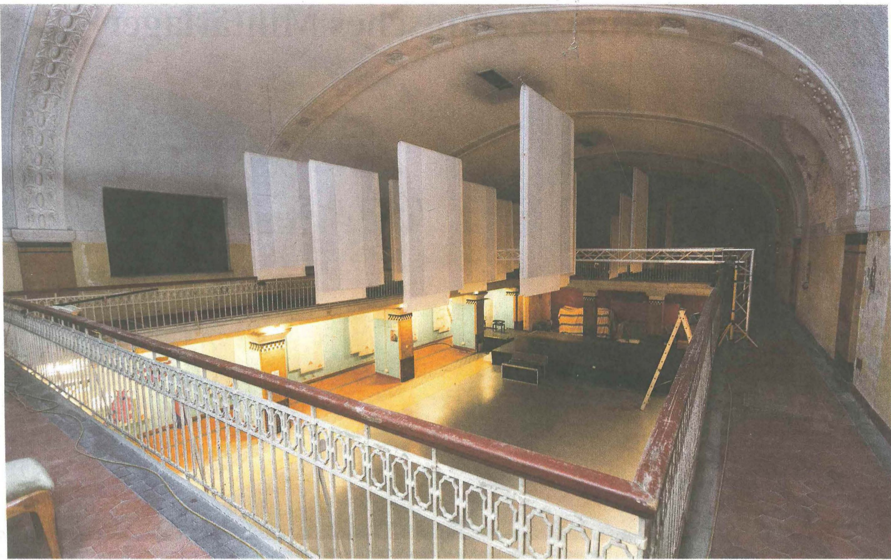
Umwidmung: Das Alte Hallenbad ist derzeit eine Baustelle, es wird in eine Location für Theater und Konzerte umgebaut.
